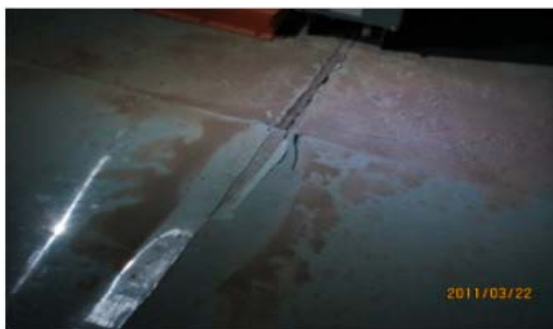
図4：エキスパンションジョイントから吹き上げた泥水のあと。2011年3月22日撮影。
