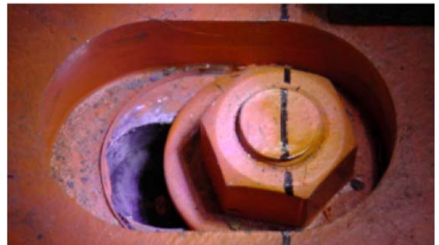
図3：エキスパンションジョイントにかかる電磁石ベースプレート。M12 ボルト用の孔は熱収縮・膨張を考慮して長穴にしてある。地震前には左側にボルトが寄っていたが地震直後にはボルトが右側に寄っていた。この移動量はコンクリートの熱膨張係数で想定される量よりも遥かに大きい。なお、写真縦に入ったマジック線は地震後の4月にマークしたもので、4月以降にこのボルトは大きくは動いてないことを示す。
