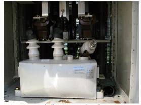
図3 損傷したサージアブソーバー
