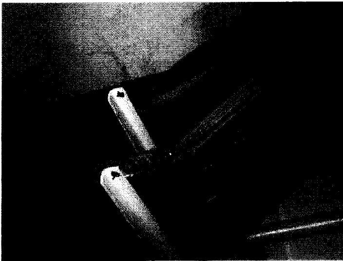
6-A 光ケーブル配線 施工後
