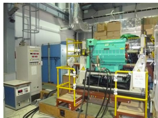
図1: 写真中央右側が四極電磁石及び磁場測定ステージ 左側奥に励磁用の電源 左側手前にステージと測定コイルをコントロールする為の制御盤
