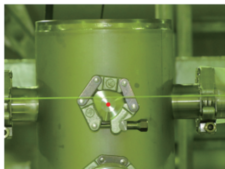
図 4: ACS11 区間のビームダクトのずれと糸による高さの再確認
