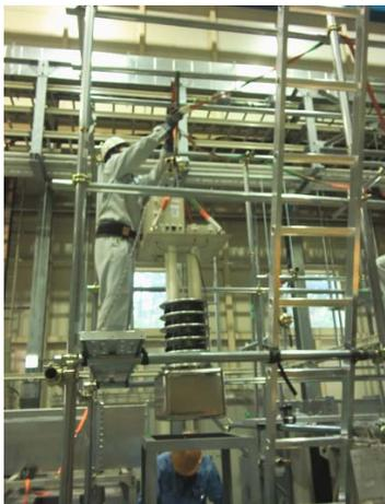
図5. M-アノード変調器のスイッチングユニット交換作業風景
