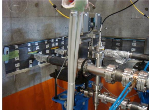
図6：超伝導偏向電磁石ビームラインの遮蔽壁貫通穴の鉛遮蔽。
