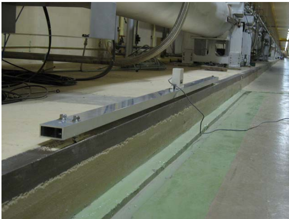
図5:床面傾斜角測定の様子、測定は手前左の上流側から、右奥の下流側に向かって行われた
