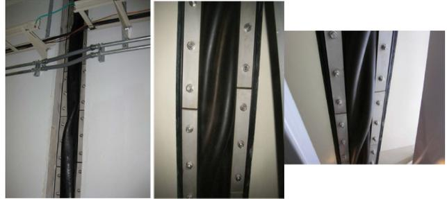
図 2：トンネルの変形によるエキスパンションジョイントの損傷状況
