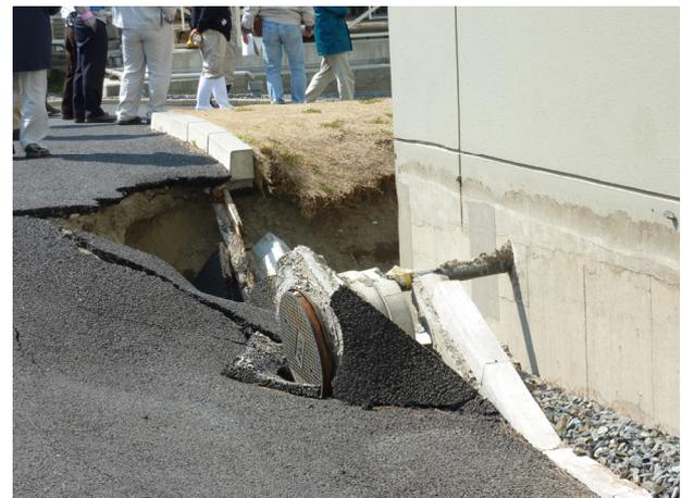
図 3：建物周囲陥没と配管の破断
