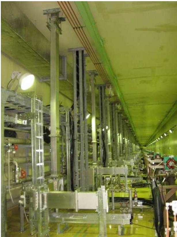
図5 加速器トンネル内の導波管敷設状況
