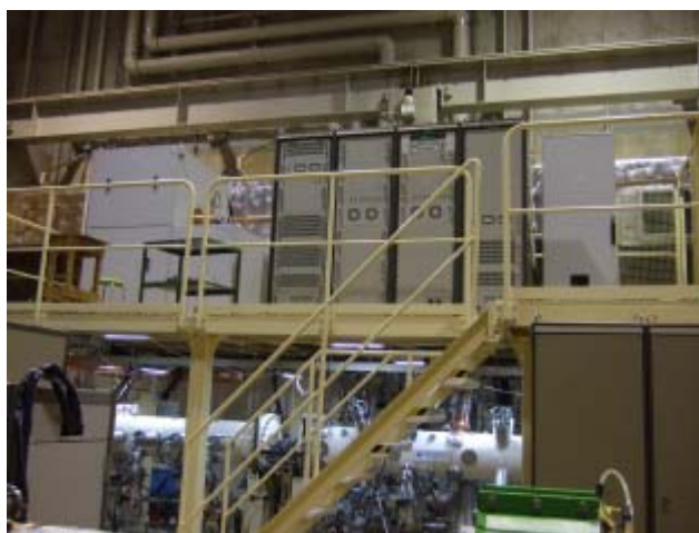
図7 . プラットホーム上に高周波 増幅器一式を据え付けた
