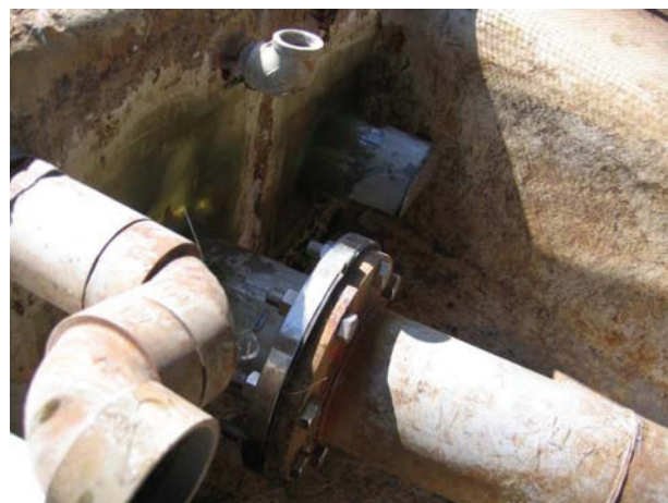
図6：ステンレス配管に交換された冷却塔
