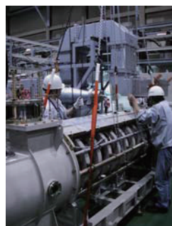
図3：クライストロン設置 図4：アンカー固定
