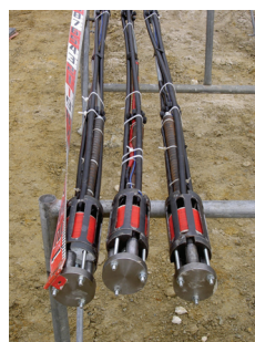
写真3：除去式アンカー
