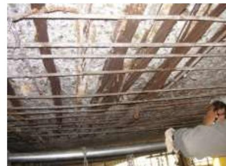
PC鋼材の腐食・破断
