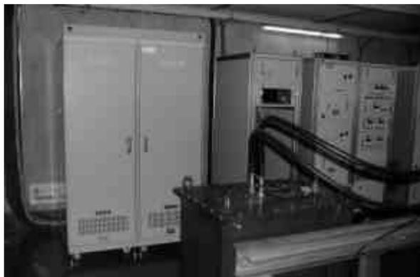
図2 電子銃高圧タンクの脇に置かれた加速器本体室のDCS筐体(左)。RFパワー伝送路の制御盤(中央)、サブハーモニックバンチャー用RF源(右)。
