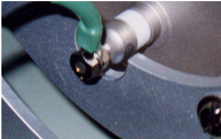
G1接続端子での放電痕
