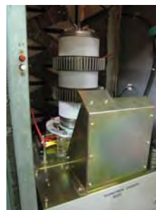
サイラトンの設置
